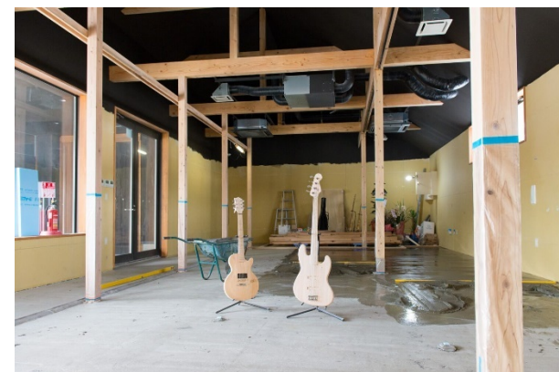
新設した女川工場の様子
