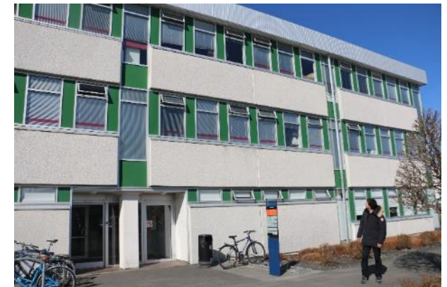
シェアオフィスが入居する大学施設の外観
